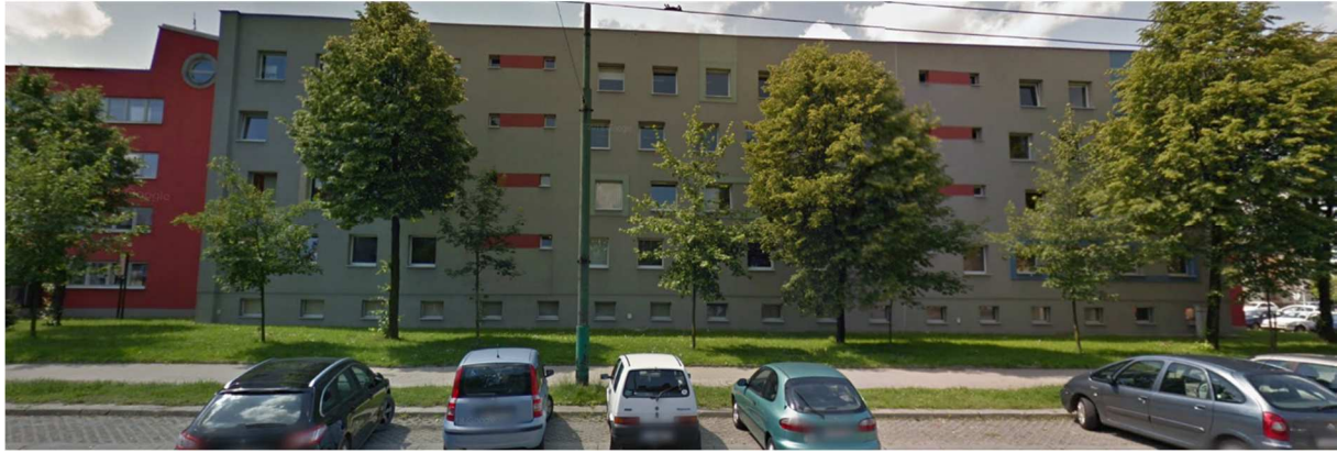
widok elewacji budynku przy ul. Budowlanych 59
